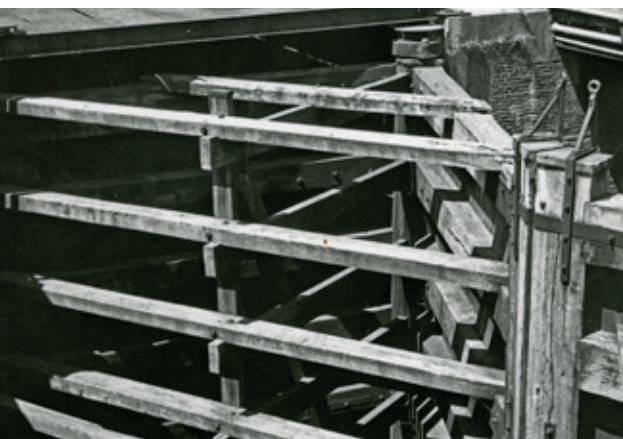
Een van de twee waaiersluisdeuren van de sluis bij Werk aan het Spoel op een foto uit 1940. Regionaal Archief Rivierenland, Tiel
