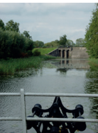
De beersluis gezien vanaf de damsluis in de rondweg. Foto uit circa 2014. Chris Will, Everdingen
